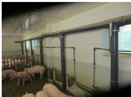
Beispiel: Befindet sich zwischen einem vor dem Fenster verlaufenden Heizungsrohr und der Fensternische ein Abstand, sodass Licht auch oberhalb durchkommt und am Rohr vorbeifließt, kann die gesamte Fläche berücksichtigt werden. Wenn die Fensternische – wie im nebenstehenden Bild – durch ein Rohr verkleinert wird, zählt die so verkleinerte Nischengröße und nicht mehr das Fenster selbst als Lichtfläche.
